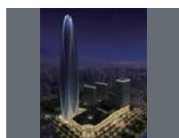
宁波中心 在建 Ningbo Center Under Construction
